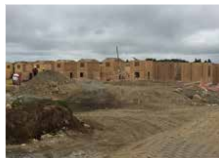
Casa Alta Esperanza Color blanco / Puerto Montt Constructora Baquedano
